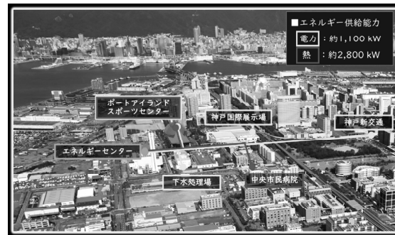
神戸市ポートアイランドで実証されている水素エネルギー利用システム (出典：神戸市)
