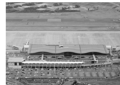
仙台空港の全景（仙台国際空港株式会社提供）。
